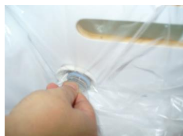
○排水受け口に排水用ラップ口をあてがい、排水の位置を決め、排水用ラップ口を差し込む
