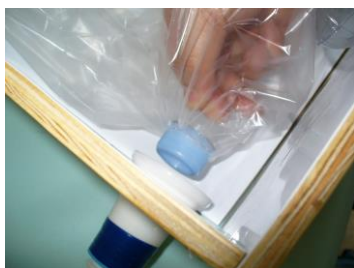
○排水の受け口にビニールシートに装着した蓋を押し込む
